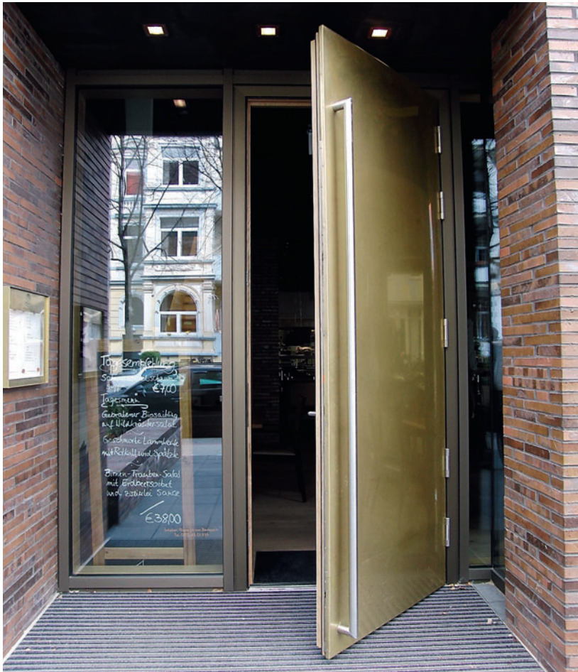
/ Die Eingangstür zum Restaurant wurde ebenfalls von Becker & Sohn gefertigt und ist von einer ortsansässigen Firma mit Messingblech bezogen worden. (Foto: Autorin)
